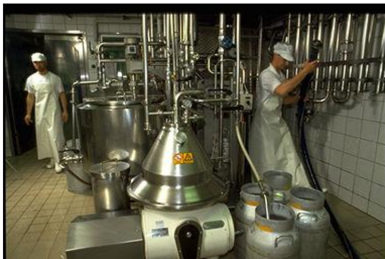
Foto LMZ / Technische Einrichtung im Betrieb
