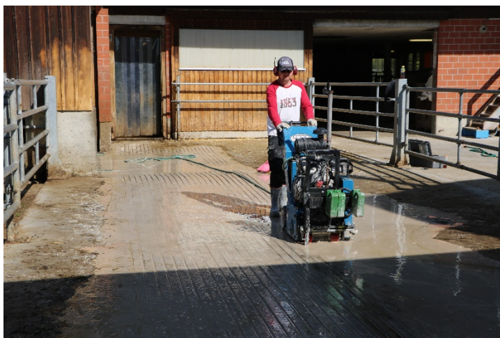
Abbildung 4; TrakRite Fräsmaschine im Einsatz (Quelle: Jonas Bürgi)
